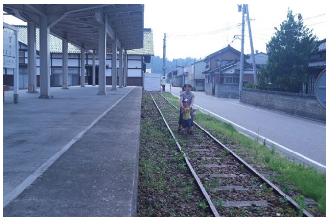
一部線路が敷設している状態
